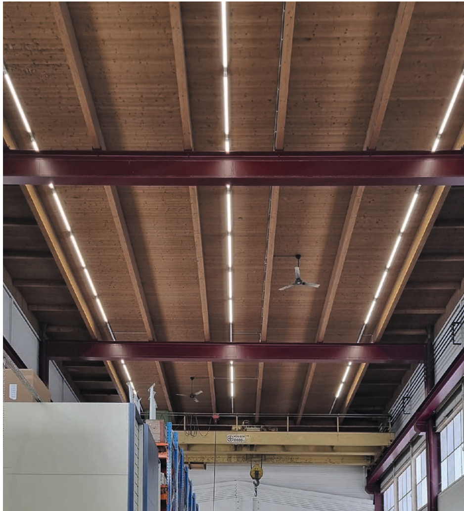
Die neu eingesetzten Lichtbänder bieten besseres Licht und verbrauchen deutlich weniger Strom als die alte Beleuchtung. (Bild: Nevalux AG)
